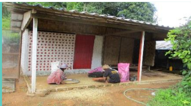
シードバンク保管施設
