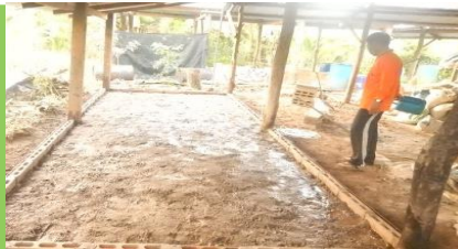
シードバンク施設の床建設
